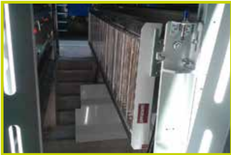
Vista forno I.R. in manutenzione Vue four I.R. sous entretien
